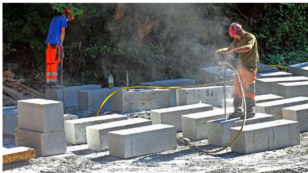
Für die Verankerung müssen Löcher in die Granitblöcke gebohrt werden.
