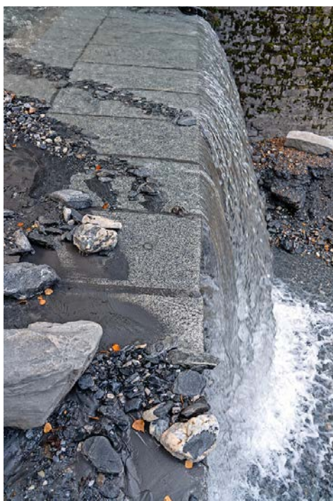
Auch bei Sperre Zwei wurde die Abflusssektion mit kubischen Granitblöcken instandgesetzt.
