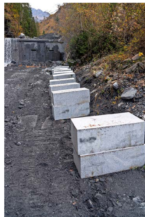
Natursteinblöcke für die Sanierung der Abflusssektion der Vorsperre Sechs liegen bereit.
