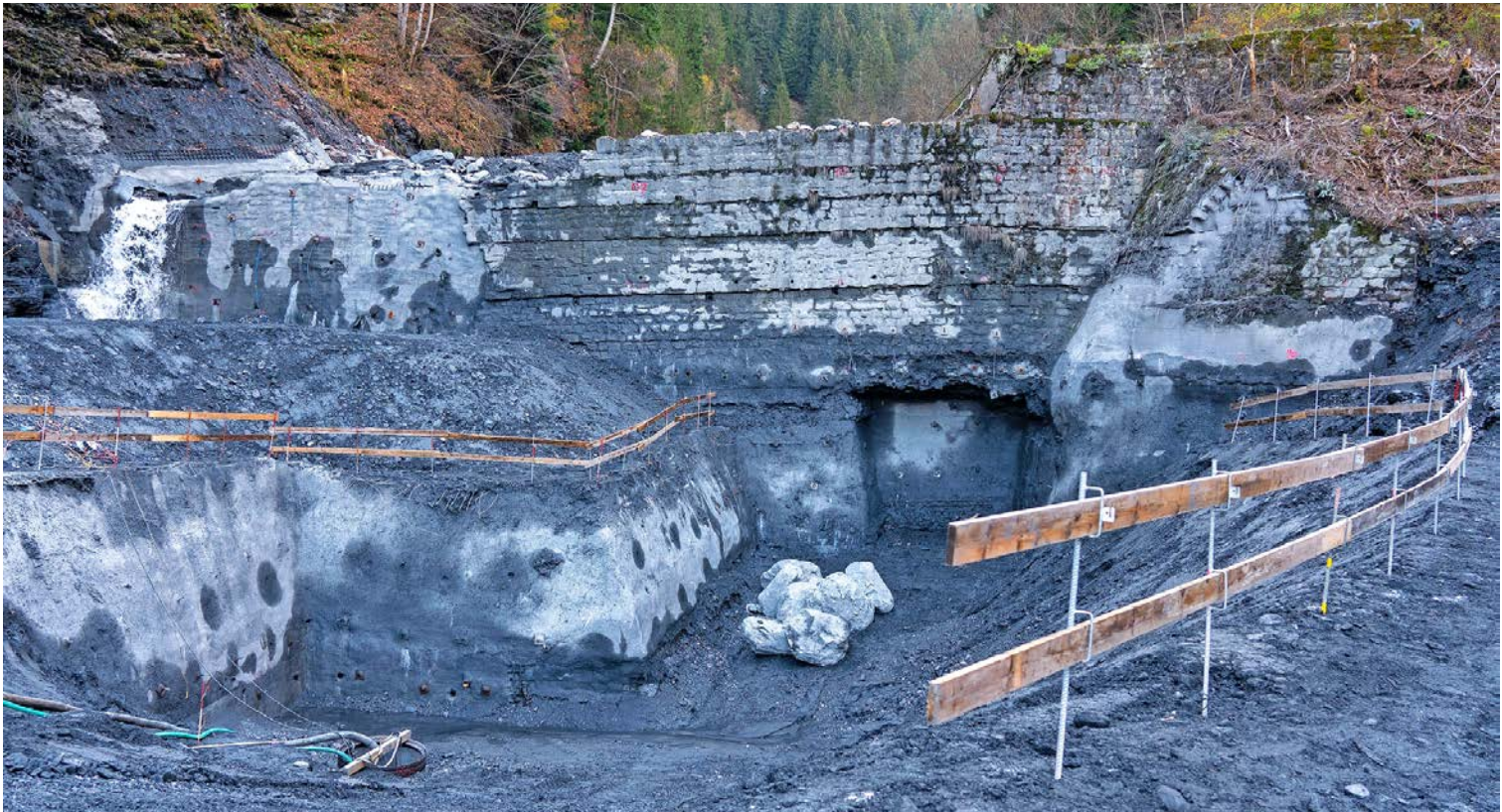
Die Fundationsarbeiten an der desolaten Sperre Acht, für die ein Ersatzbau unmittelbar vor dem bestehenden Bauwerk erstellt wird, sind bereits angelaufen.
