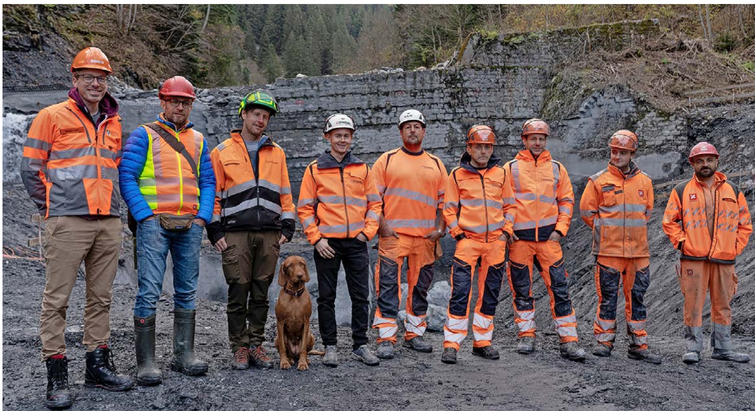
Das Instandsetzungsteam vor der Sperre Acht (von links): Projektleiter Richard Käch (Tiefbauamt Graubünden), Ivo Thaler (Fachbauleiter), Philip Christen (Vertreter der Bauherrschaft), Fabian Canal (Bauführer), Andrea Rüttimann (Polier), Manuel Moar und Christian Giger (Maschinisten) sowie Dominik Kunfermann und Nuno Cardoso (Bauarbeiter). Bilder Pius Furger
